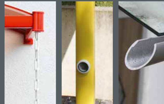
Kette Entwässerung durch Stütze Rinne
